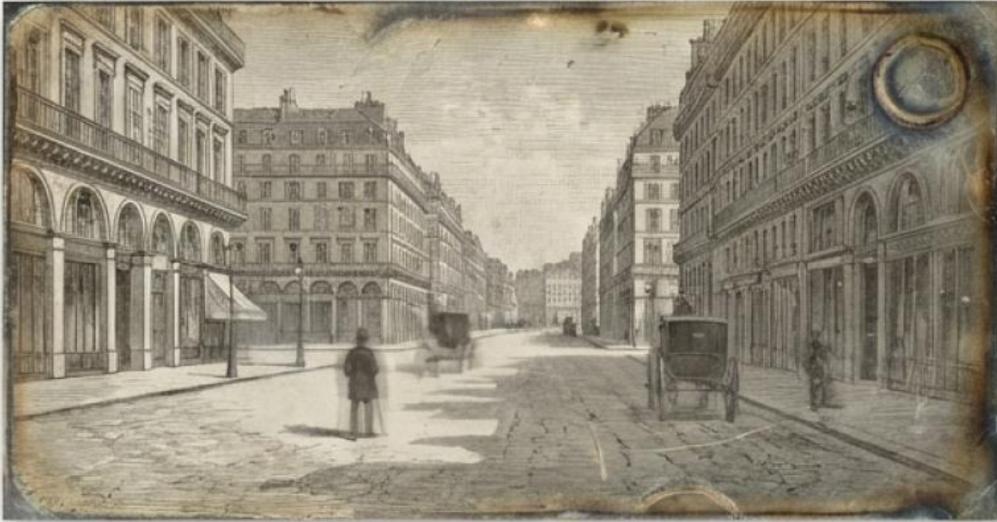
Avant 1880 : La pose
